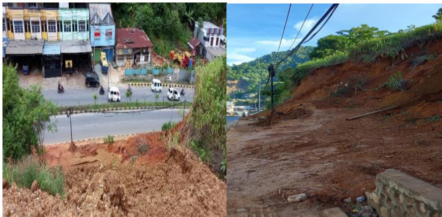
Gambar 1. Lokasi penelitian lereng di ruas jalan raya Abepura-Sentani
