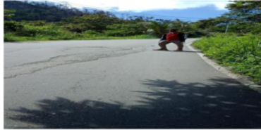
Gambar 7. Retak Blok (Dokumentasi Lapangan 2020)
