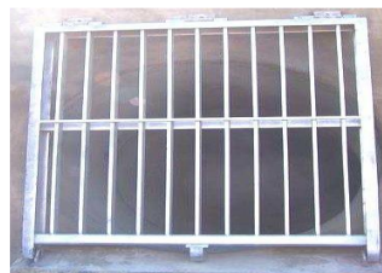
Gambar 5. Penggunaan Trash Rack pada saluran drainase
