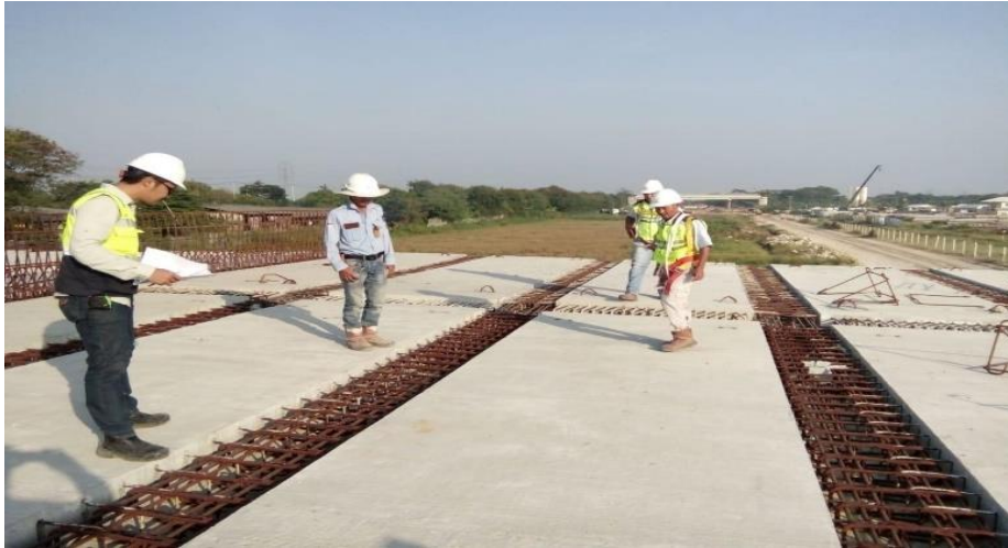
Gambar 5. pemasangan Full Slab di lokasi pileslab
