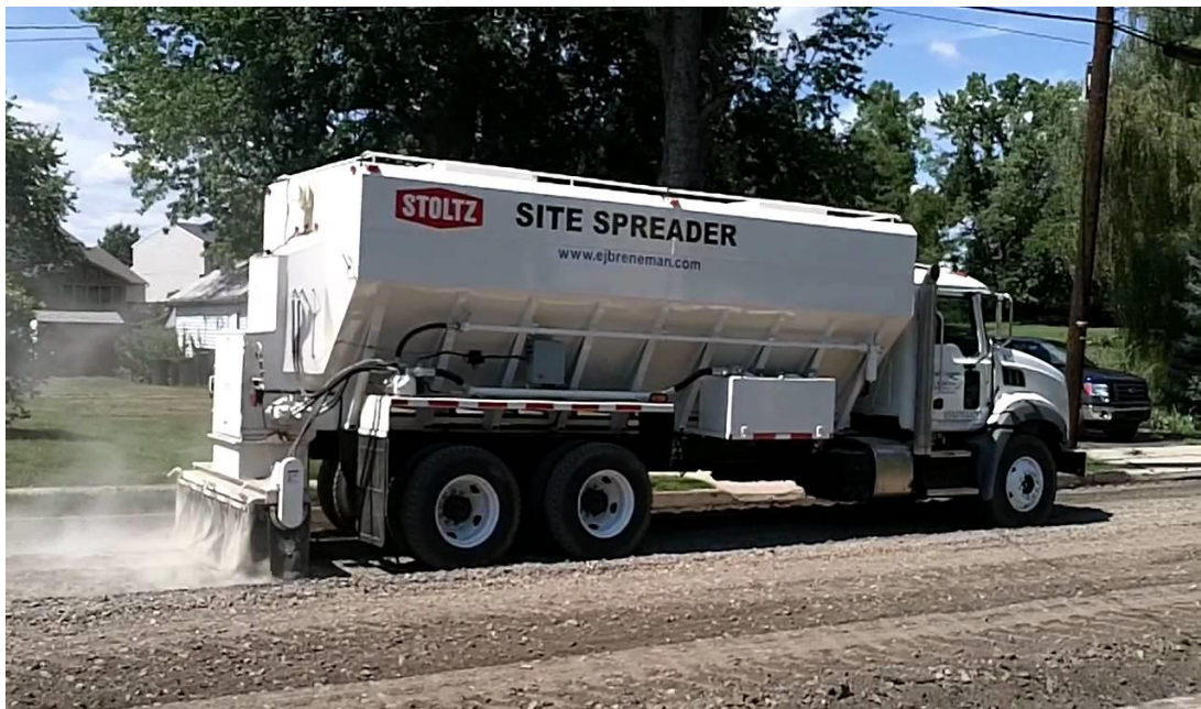
Gambar 4. Penebaran semen dengan Cement Spreader
