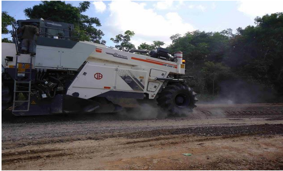
Gambar 5. Milling campuran semen tanah dengan alat Recycling Machine (WR.2500)
