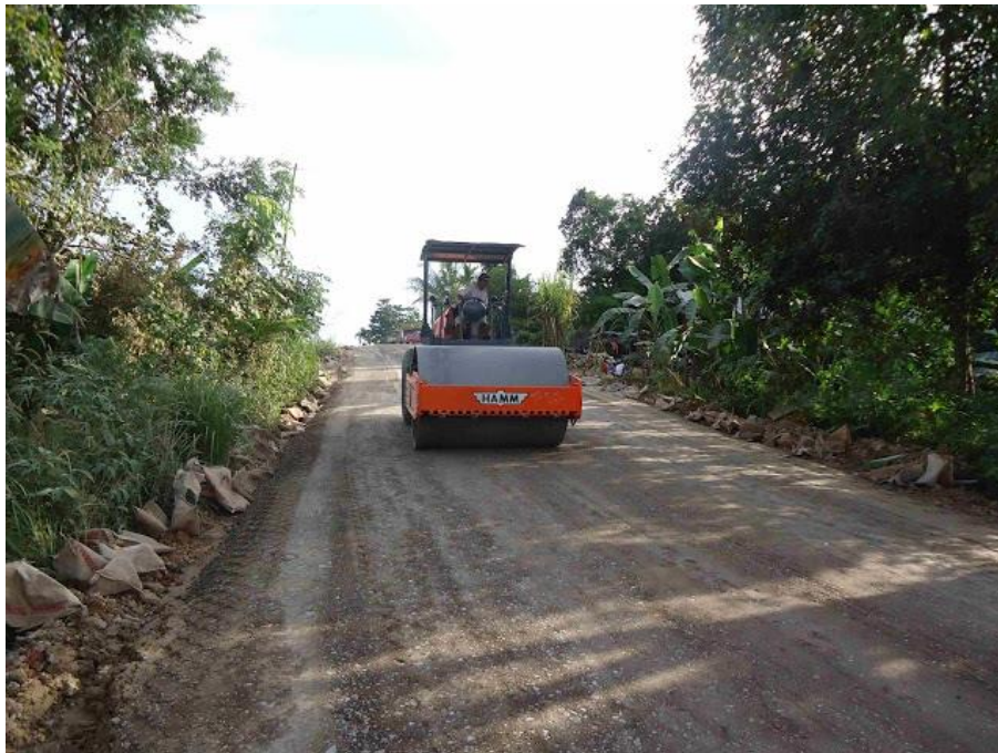
Gambar 9. Pemasadatan akhir dengan Smooth Drum Roller
