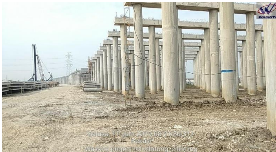
Gambar 6. Kondisi Full Slab di lokasi proyek
