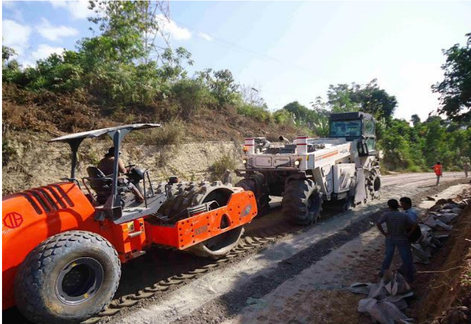
Gambar 7. Pemadatan awal dengan Padfoot Roller
