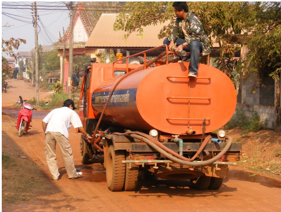
Gambar 6. Penyiraman dengan Water tank Truck
