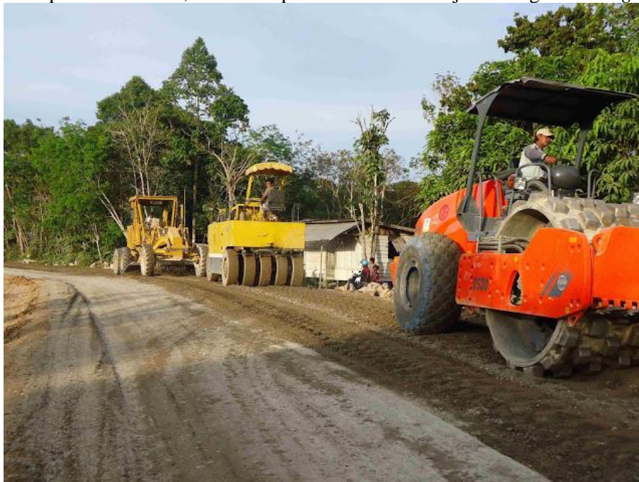
Gambar 8. Pemadatan dan pembentukan badan jalan
