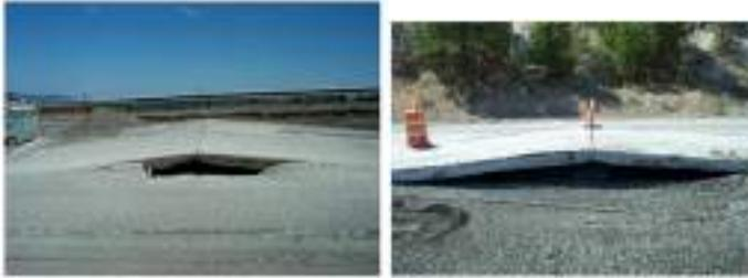
**Gambar 12.1:** Jenis kerusakan blow up (buckling) (Pemeliharaan Jalan, 2017)
