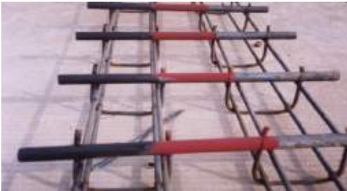
**Gambar 2.6:** Ruji pada perkerasan kaku bersambung tanpa tulangan
