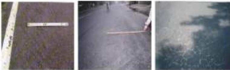
**Gambar 9.7:** Patah slip, megembang jembul dan pelepasan butir Bina Marga no.03/MN/B/1983
