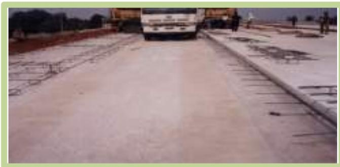
**Gambar 2.8:** Kedudukan batang pengikat pada sambungan memanjang
