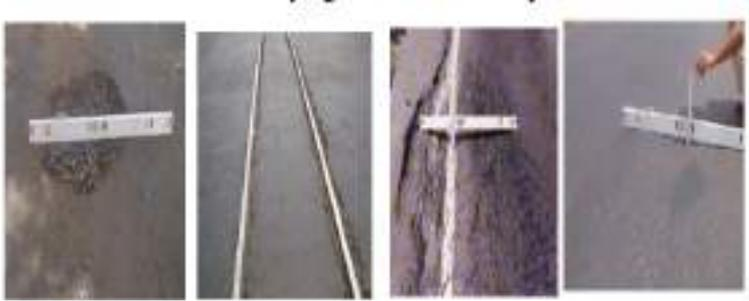
**Gambar 9.6:** Lubang, perpotongan rel, alur dan sungkur. Bina Marga no.03/MN/B/1983
