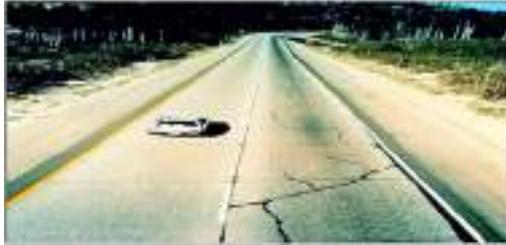
**Gambar 12.6:** Retak pelat pada lajur yang sering dilalui truk (Pemeliharaan Jalan, 2017)
