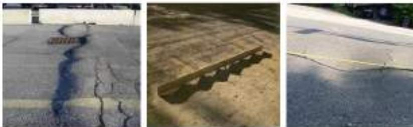
**Gambar 9.3:** Cekungan, bergelombang/keriting dan amblas Bina Marga no.03/MN/B/1983
