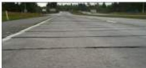
**Gambar 12.3:** Faulting (Pemeliharaan Jalan, 2017)
