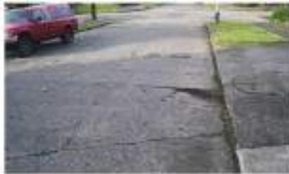
**Gambar 12.2:** Rusak sudut Jalan Permukiman (Pemeliharaan Jalan, 2017)
