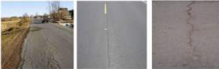
**Gambar 9.4:** Retak pinggir, retak sambungan dan pinggiran jalan turun vertikal. Bina Marga no.03/MN/B/1983
