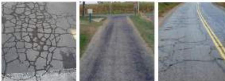
**Gambar 9.2:** Retak Kulit Buaya, Kegemukan dan Retak Kotak-Kotak
